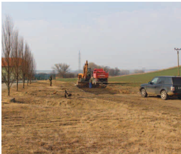
Zahájení stavby cesty k rybníku Na Zumru.
