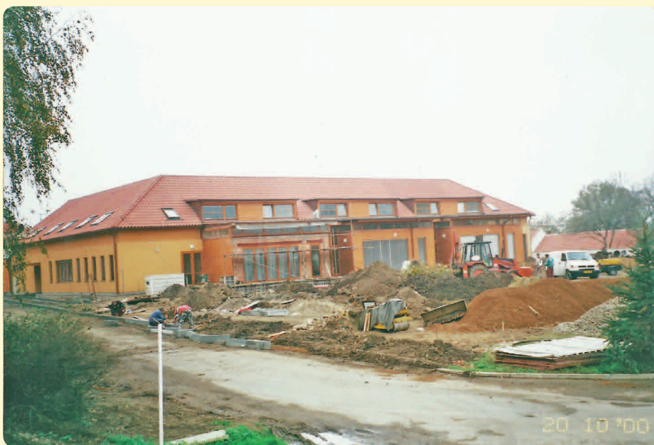
Dům pana Khuny je již odstraněn. Tato fotka je z 20. 10. 2000. Na slavnostním zahájení, které se konalo za 14 dnů (4. listopadu 2000), byly již hotové terénní a parkové úpravy!
