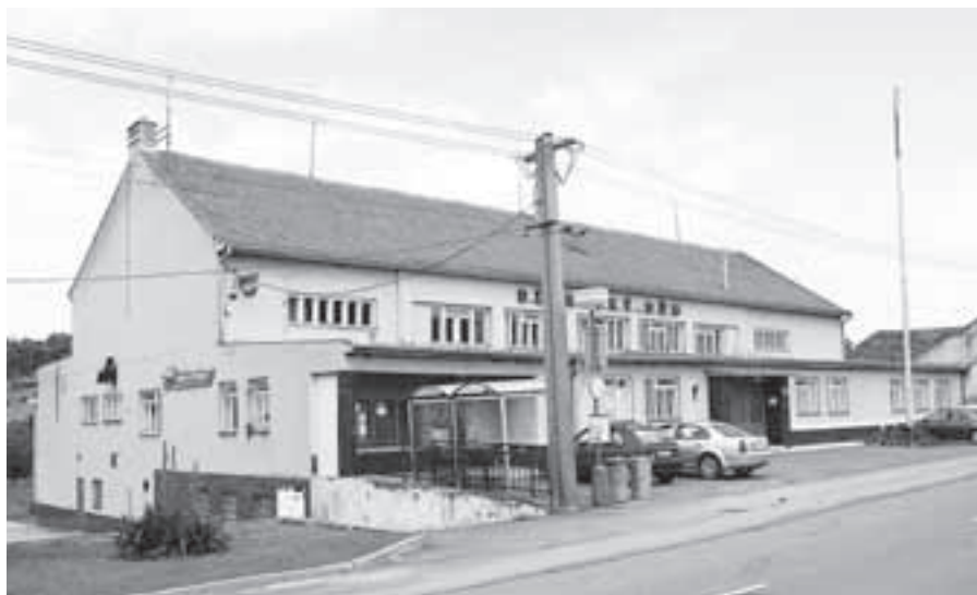
Dělnický dům čeká o prázdninách rekonstrukce.
