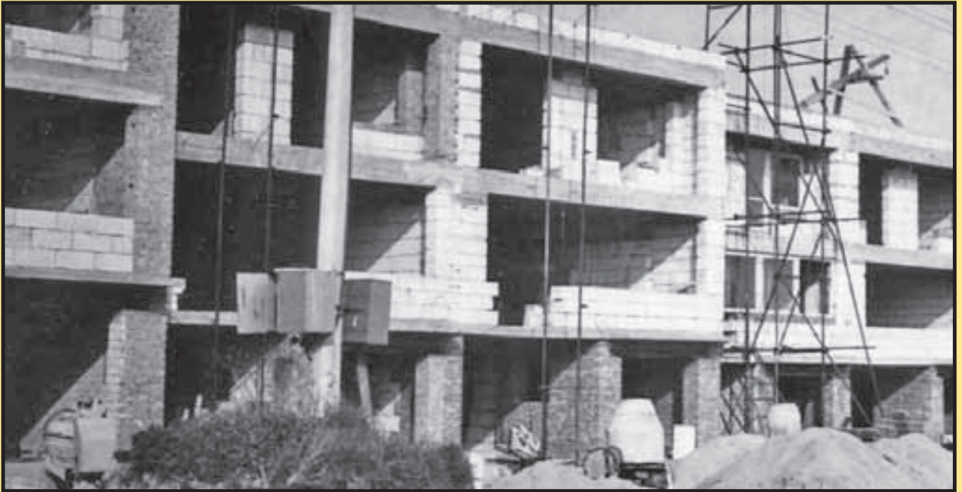
Stavby rodinných domů na ulici Lipová v roce 1979...
